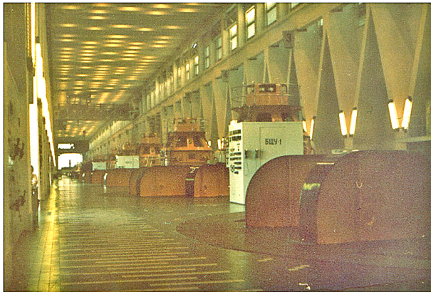
Turbinensaal des Bratsker Wasserkraftwerkes
