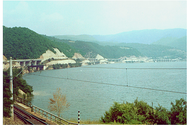
Straßen- und Eisenbahn-Viadukte
