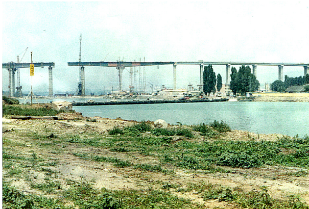
Neue Brücke über die Varnaer Bucht
