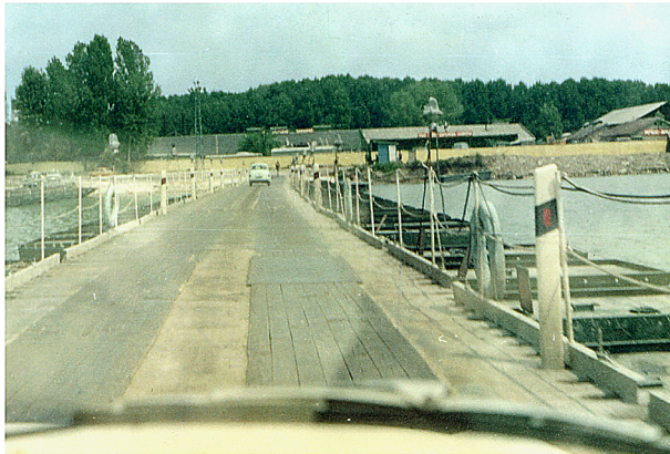
Pontonbrücke über die Varnaer Bucht
