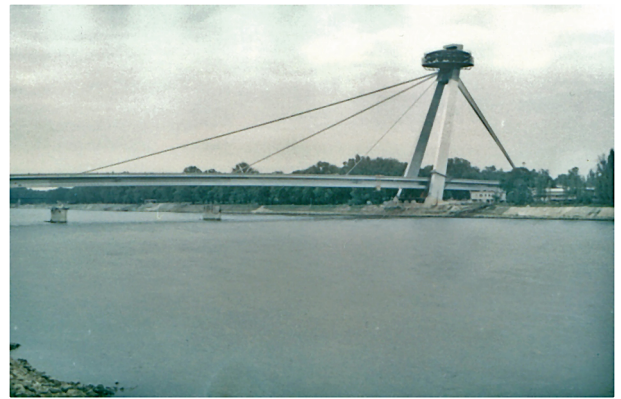
Donaubrücke in Bratislava
