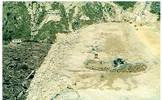
Damm am Vidra-Stausee im Bau
