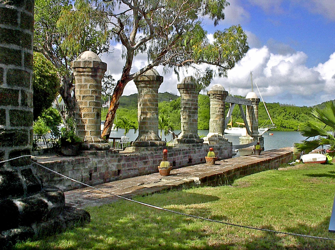
Antigua - Nelsons Dockyard
