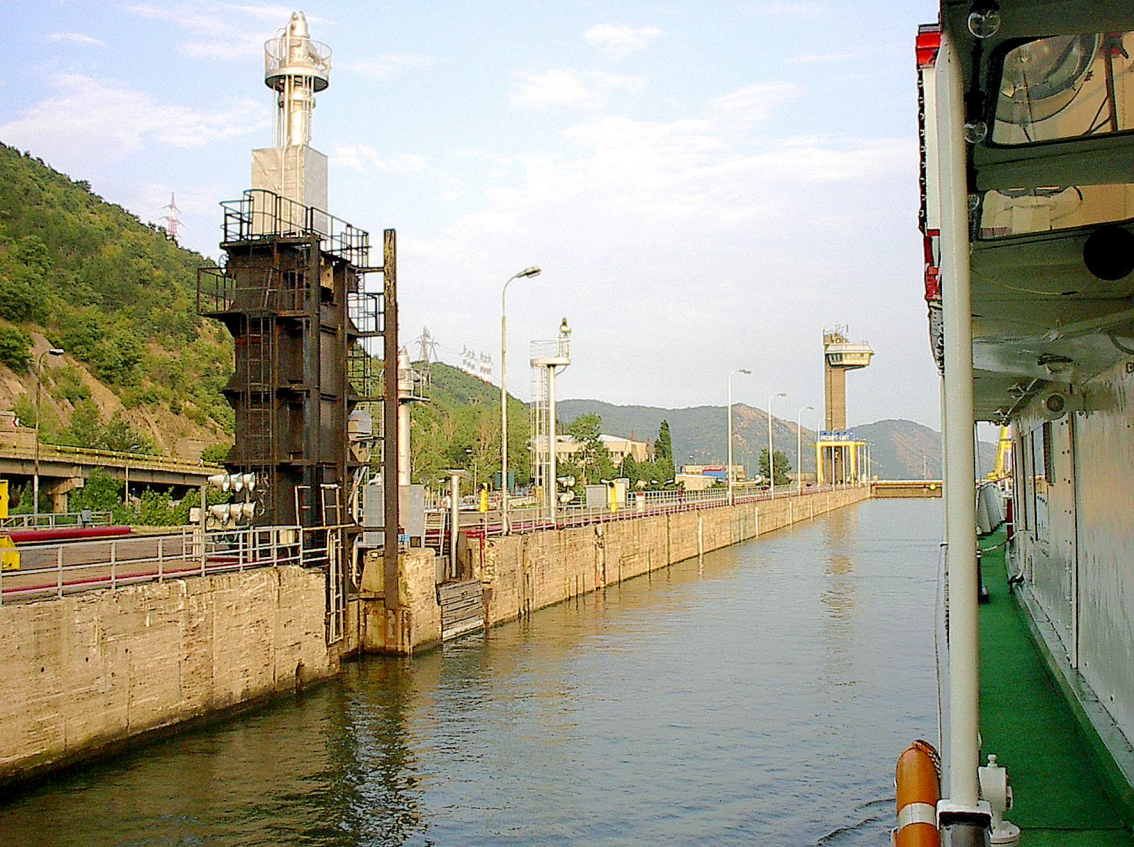
Donau - Stauwerk Djerdap 1 bei Km 944
