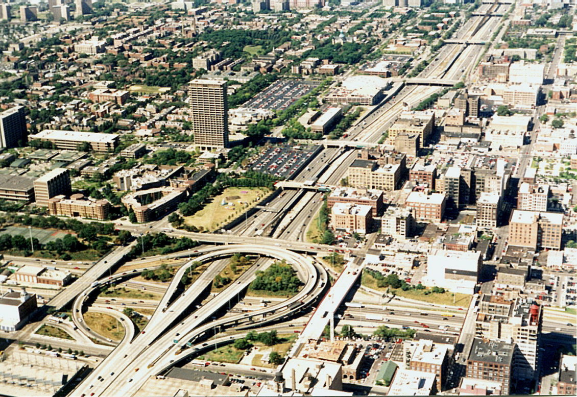
Chicago: Blick vom Sears-Tower nach Westen
