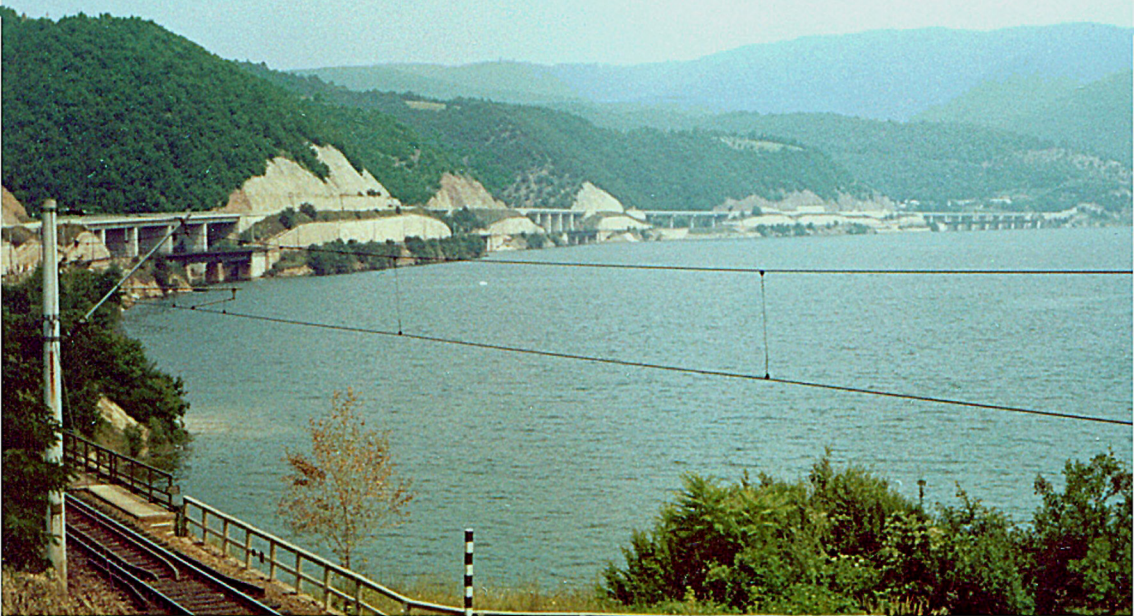
Straßen- und Eisenbahn-Viadukte
