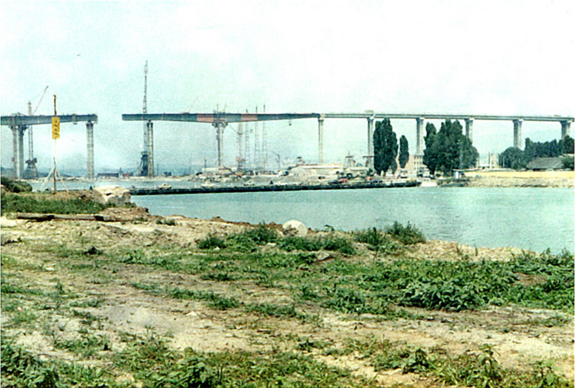
Neue Brücke über die Varnaer Bucht
