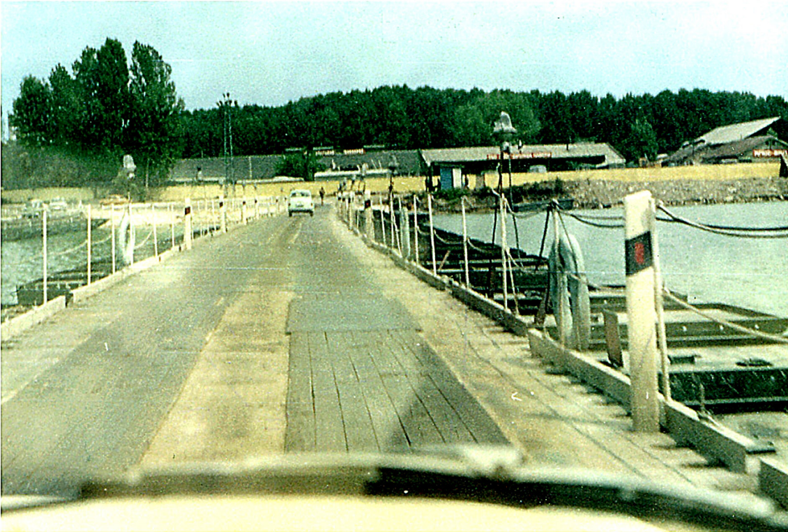
Pontonbrücke über die Varnaer Bucht
