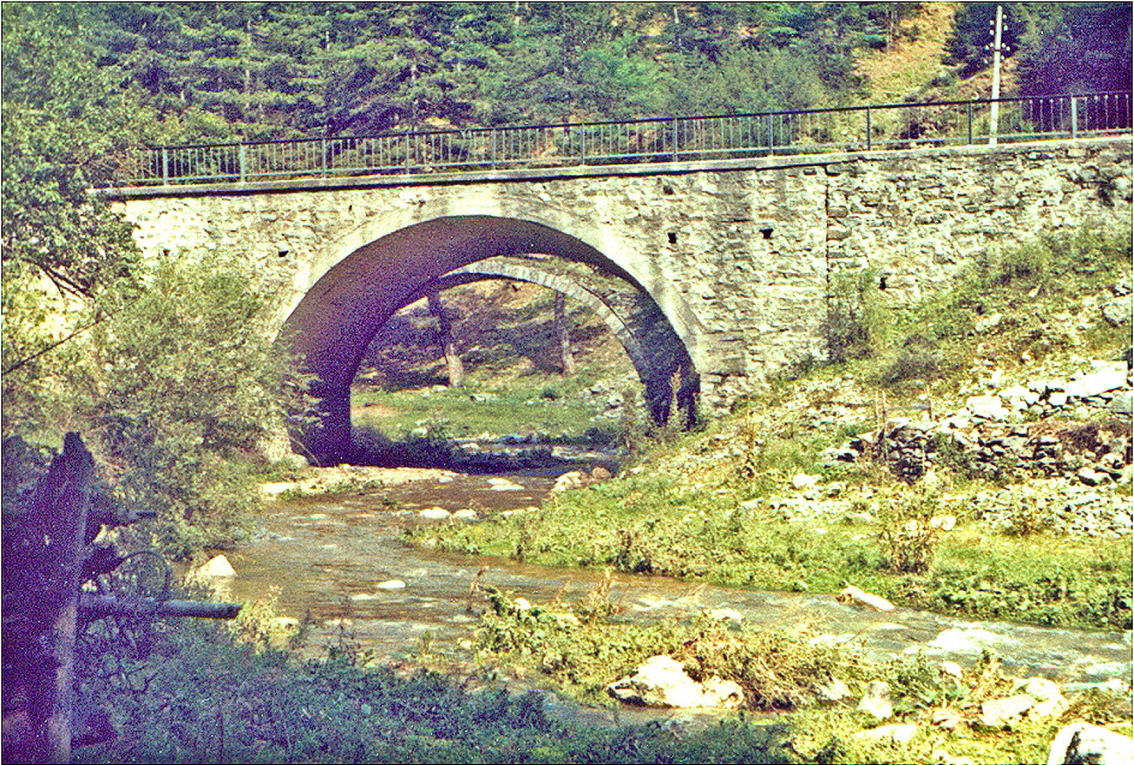
Brücken zwischen Cepelare und Roschen Paß
