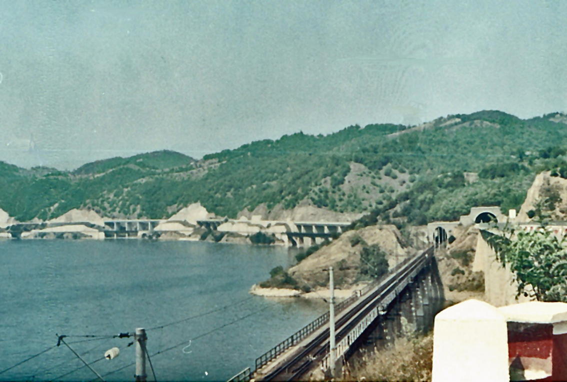
Neue Straße und Bahnlinie am Donau-Stau
