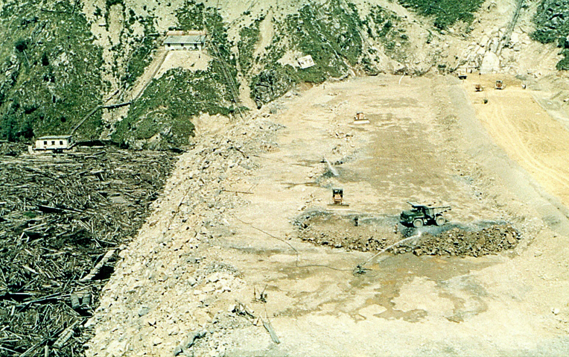
Damm am Vidra-Stausee im Bau
